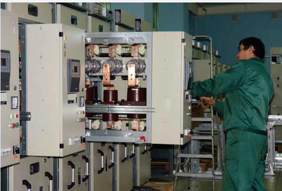
Рис. 5.3. «Ремонтное» положение моноблока
