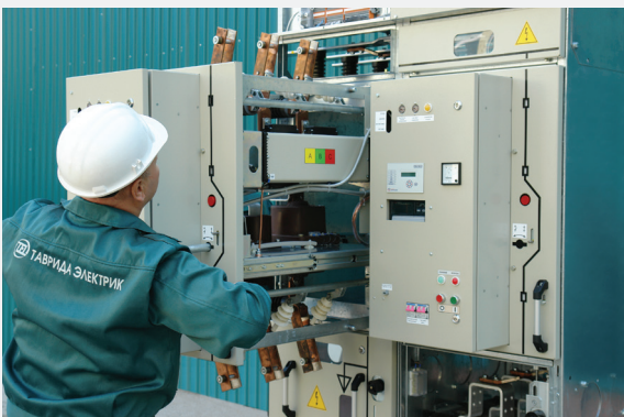
Рис. 5.4. Шинный и линейный разъединители
