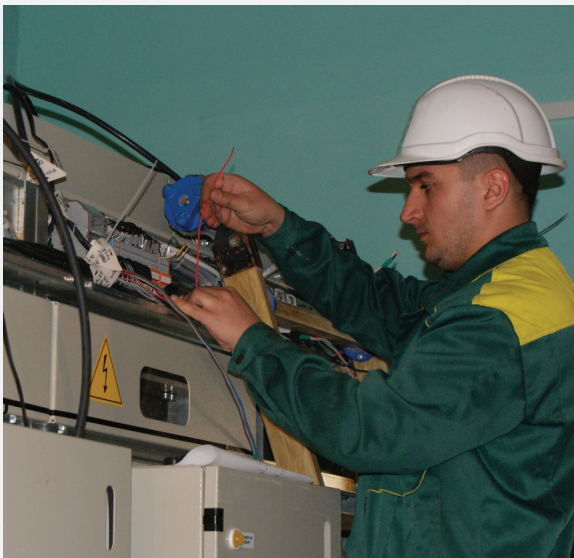
Рис. 5.13. Прокладка транзитных цепей
