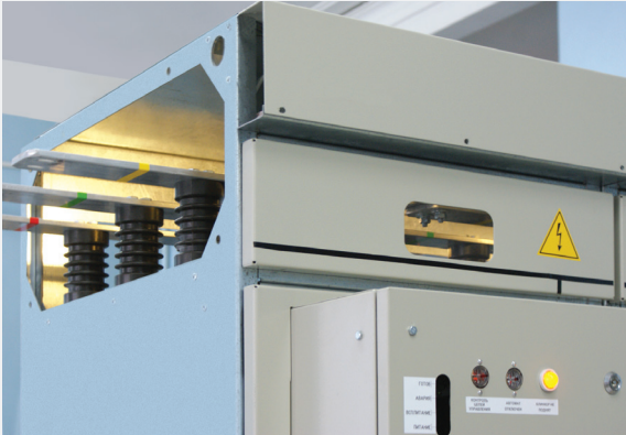
Рис. 5.2. Отсек сборных шин
